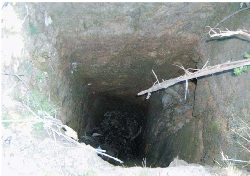
**Figura 12.** Poço de secção quadrangular nas Minas das Banjas.
